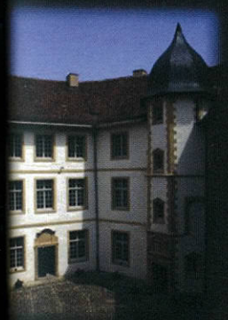
Château Saint-Sixte, Freistroff Restauration de l'aile XVIIIème siècle
