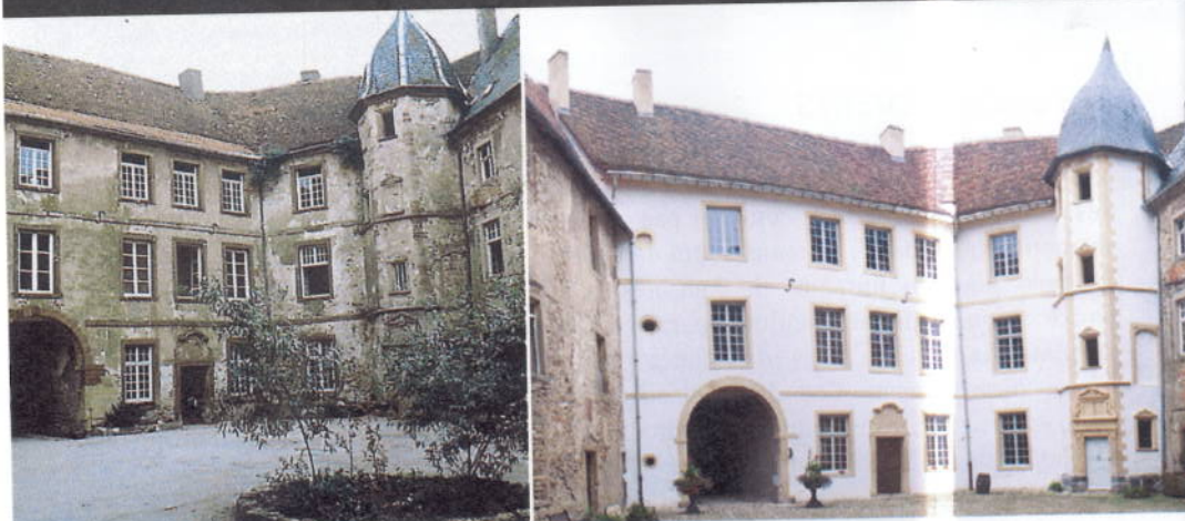
Le château de Saint-Sixte avant et après restauration.
